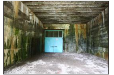
La porte du tunnel. L'intérieur n'est plus accessible : c'est aujourd'hui un site géré par la Lyonnaise des eaux. Photo L'Alsace
